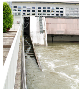
Abb. 6. Bestehender Beckenpass beim Kraftwerk Säkingen
